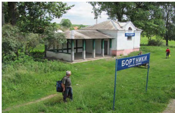
Рис. 41. Будівля станції Бортники
