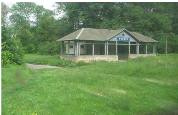
Рис. 40. Будівля станції Бовшів
