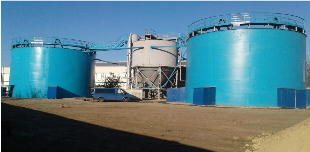
Рисунок 1 – Аеротенки-відстійники підвищеної гідравлічної висоти діаметром 14,0 м на очисних спорудах маслоробного комбінату
