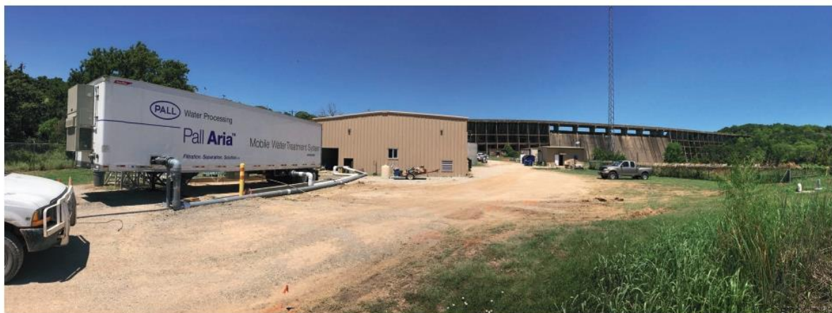
Рис. 2. Мобільна водоочисна система в місті Кіско
