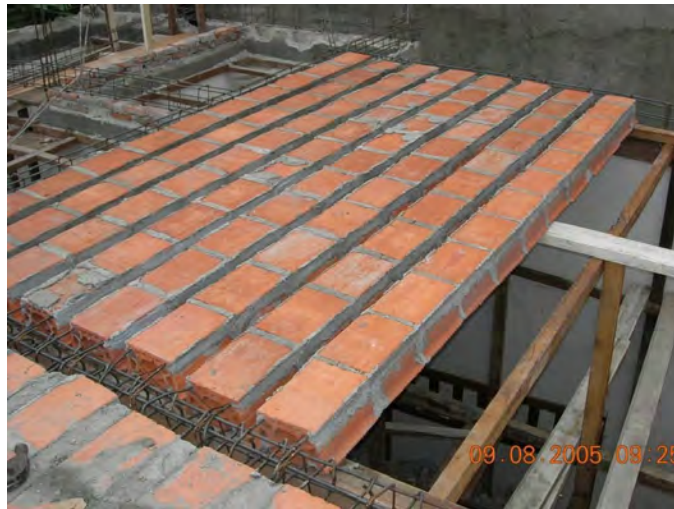
Рис. 1. Керамоблокове перекриття "Abadi Ceiling Brick"
