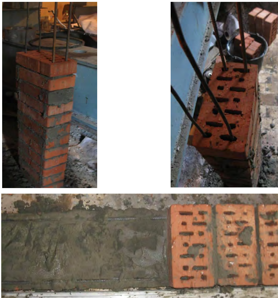
Рис. 2. Процес виготовлення балок Б-1, Б-2, Б-3
