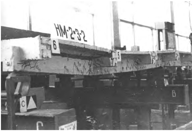
Фото 3. Характер тріщиноутворення в дослідній конструкції нерозрізної прогонової будови з діафрагмами
