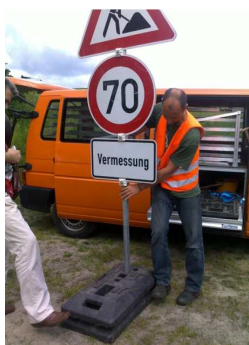
Рис. 1. Встановлення попереджувальних дорожніх знаків
