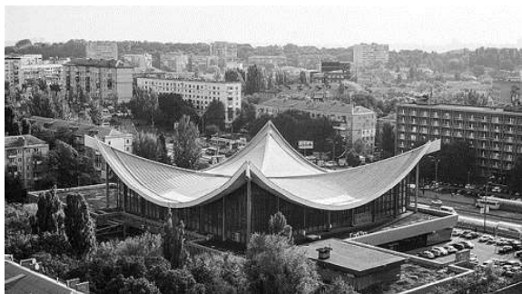
Рис. 5. Київ. Будинок меблів. Архітектор Наталія Чмутіна. 1984 р.
