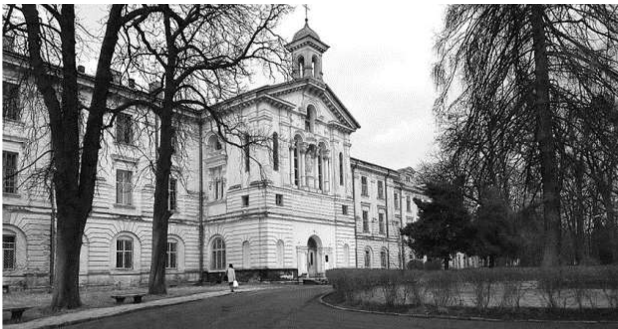
Рис. 3. Південний фасад з каплицею головного корпусу лікарні (фото автора, 2019)
