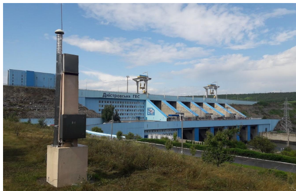
Рис. 2. Загальний вигляд споруд Дністровської ГЕС-1
