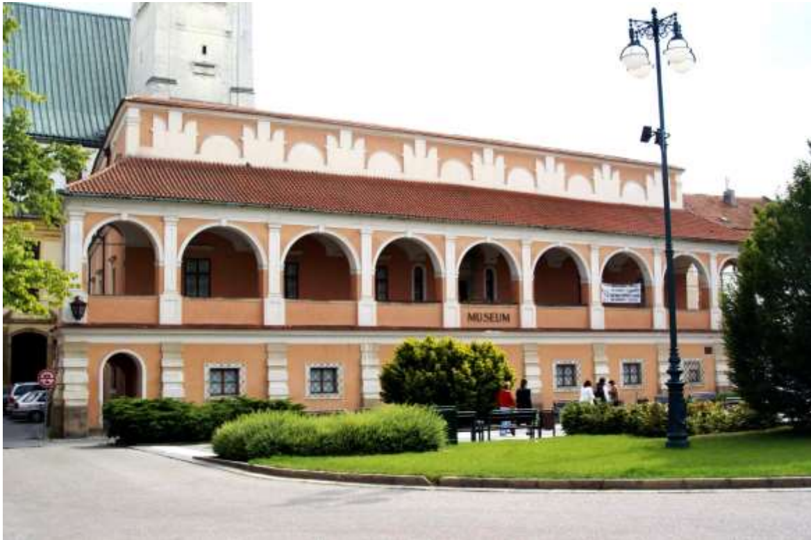
Рис. 9. Стара ратуша в Простейові (Чехія). Просвіти між зубцями півколистого аттика замуровано, аттик перетворено на горище. Фото Txlxt Txlxt, Wikimedia Commons, CC BY-SA 4.0
