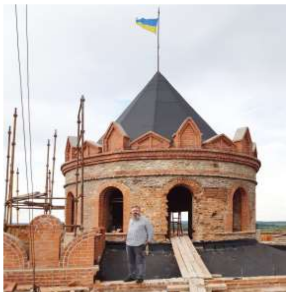
Рис. 32. Кругла вежа Меджибізького замку після реставрації зубчастого гребеня (2020 р.). Фото автора
