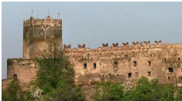
Рис. 4. Зразок ранньоренесансного аттика за М. Златом: два різновиди «півколистого» аттика замку в Болькуві (Нижня Сілезія). Будівничим вважається Якуб Парр (di Pario). Гладкий фриз, гребінь аттика як та вежі, так і на мурі утворено комбінаціями півкола та четвертини кола у поєднанні з прямокутниками. Фото Jerzy Strzelecki, Wikimedia Commons, CC BY 3.0
