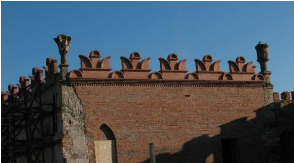
Рис. 18. Аттик палацу Сенявських в Меджибожі після реставрації зубчастого гребеня, 2018 рік. Фото автора
