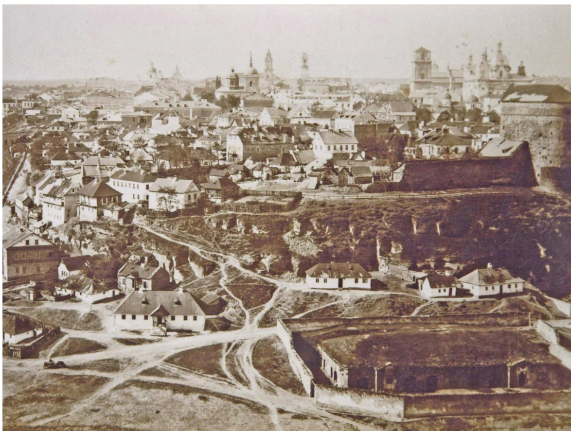
Рис. 5. Вид на місто та втрачені оборонні мури які примикали до Кушнірської башти (фото XIX ст.)
