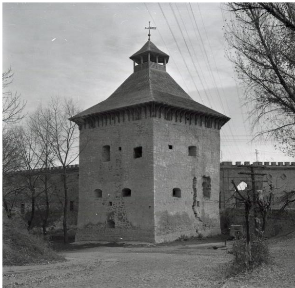
Рис. 1. «Лицарська вежа», 1983 рік (фото В. Лаценка, з фондів Державної архітектурно-будівельної бібліотеки ім. В. Заболотного)
