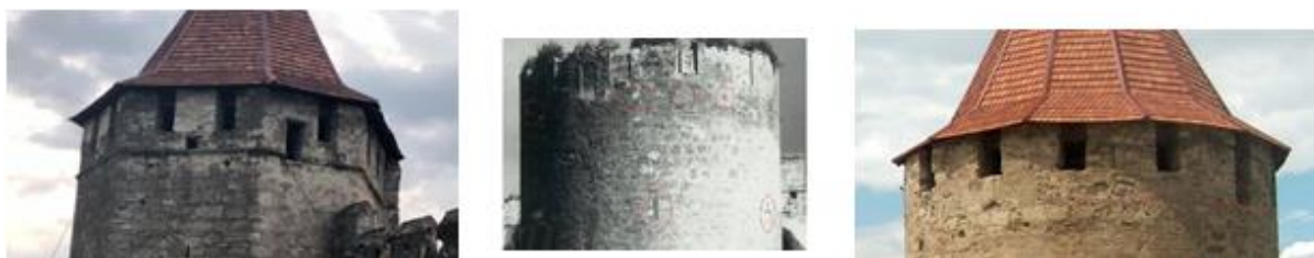
Рис.12. Башти замку з виходами на верхні галереї та «гнізда» від дерев'яних консолей. Фото Т. Нестеров 2008–2010.
