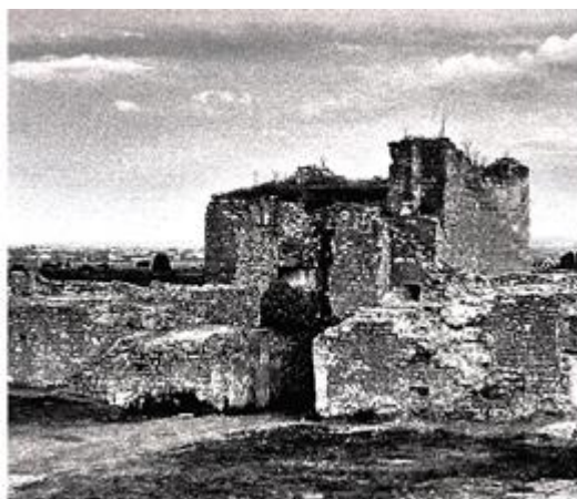
Рис. 3. Вид зруйнованої вхідної вежі з боку двору, фото до 2008 року.
