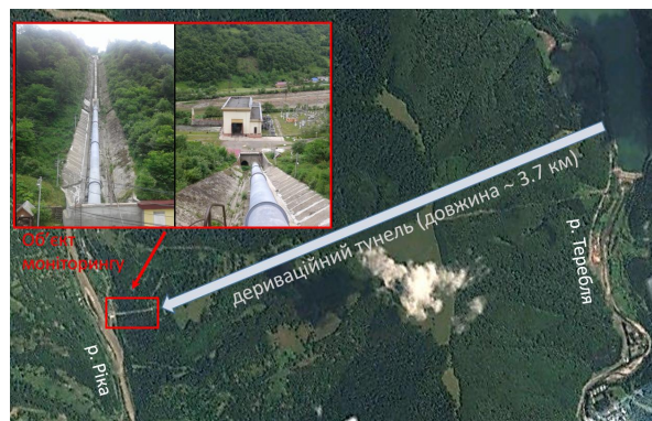
Рис. 1. Загальний вигляд на аерофотознімку та фото напірного трубопроводу Теребле-Ріцької ГЕС
