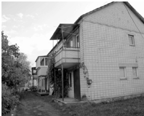
Рис. 4. Блоквані 2-поверхові 4-квартирні житлові будинки (фото автора, 2020 р.)
