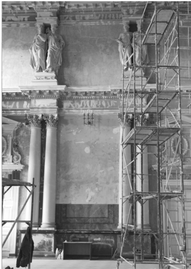
Рис. 9. Фото західної стіни актової зали у процесі ремонтних робіт 2014 р. з розкритою смугою автентичного малярського шару мармуризації у нижній частині (фото М. Бевза)
