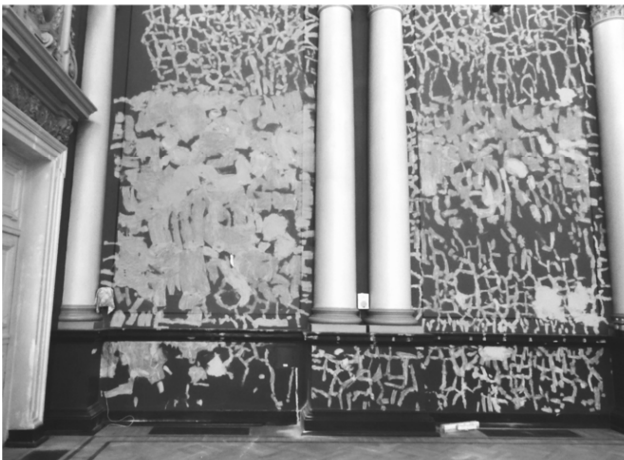
Рис. 8. Стан стін актової зали (міжколонні простінки північної стіни) з шпаклюванням тріщин у тиньку, 2014 р. (фото М. Бевза)
