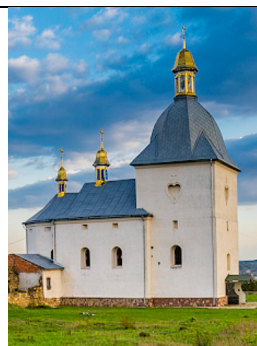
Рис.6. Загальний вигляд церкви
