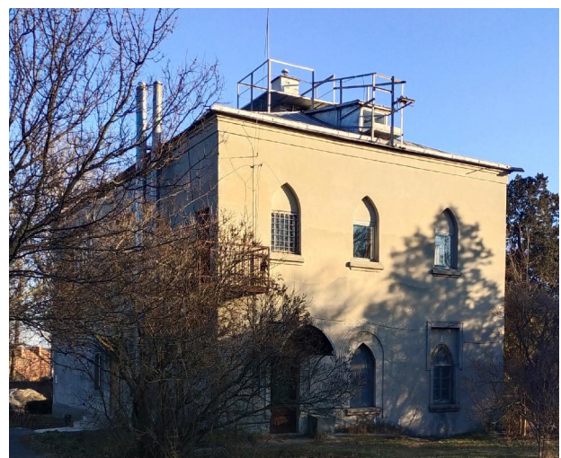
Рис. 1. Місце встановлення ГНСС-станції “Полтава” (POLV).
