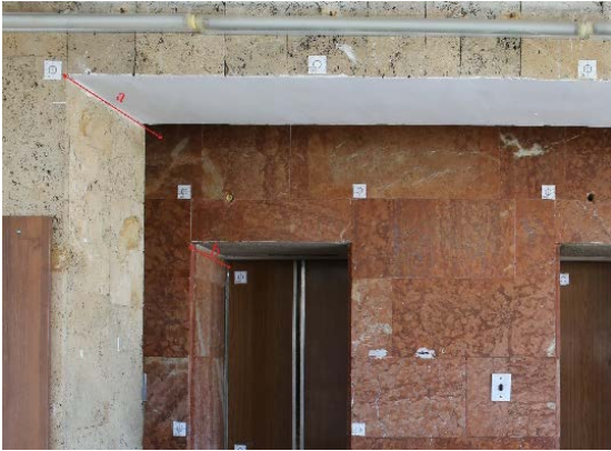
Рис. 3. Глибина об'єкта знімання відносно фронтальної проєкції ( a=105 см; b=50 см)
