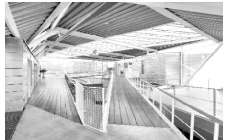
Рис. 10. Споруда Гісольярного наукового інституту (Hysolar Research Institute). 1987 р., реконструкція 2010 р., кампус Штутгартського університету, Штутгарт-Файхінген. Проєктувальник: Behnisch & Partner, архітектори: Гюнтер Бениш, Вінфрід Бюксель, Манфред Сабатке, Эрхард Транкнер. Інтер'єр Джерело: https://www.researchgate.net/figure/d-Behnisch-Partner-Catholic-University-Library-ground-floor-plan-Eichstatt_fig6_323521292
