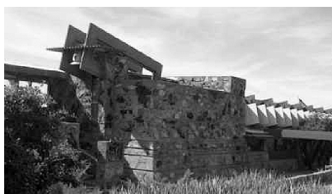
Рис. 1. Таліезин Вест, Скоттсдейл, Арізона, США. 1937 р., арх. Френк Ллойд Райт. Пластика фасаду
