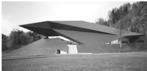
Рис. 24. Концертний зал, Ерль, Австрія, 2012 р., арх. Делуган Мейсл (Delugan Meissl) Джерело: https://www.dmaa.at/
