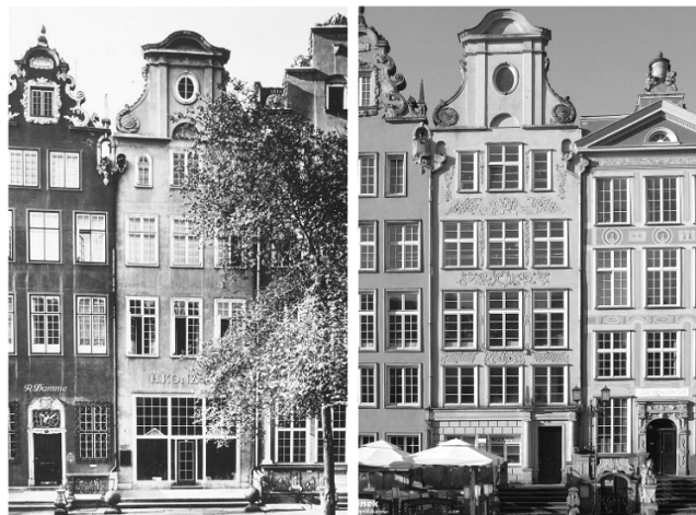
Рис. 9. Багатоквартирні будинки на вулиці Длугій, 8–10: ліворуч – фото до 1945 р., праворуч – сучасний вигляд. Змінено кількість і висоту поверхів відносно оригіналу (Gorecki, 2016 б)
