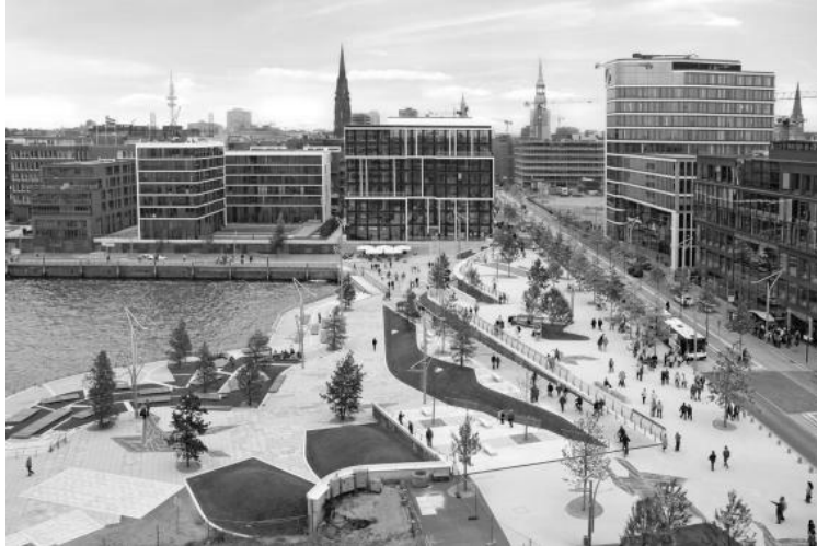
Рис. 16. Терасована набережна “Hafen-city” та житлово-офісні будівлі. URL: https://www.kcap.eu/projects/9/hafencity . (дата звернення: 9 серпня 2023)
