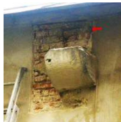
Рис. 5. Ліва консоль. Збереглося гніздо, крізь яке проходила балка галереї. Фото автора.
