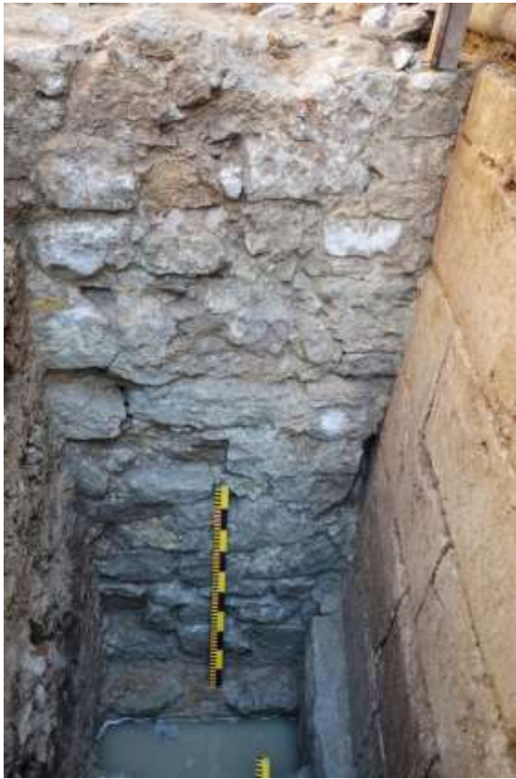
22. Фрагмент стіни (високого муру!?), мурованої з тесаних кам'яних блоків у місці прилягання вежі Пивоварів. Фото автора.
