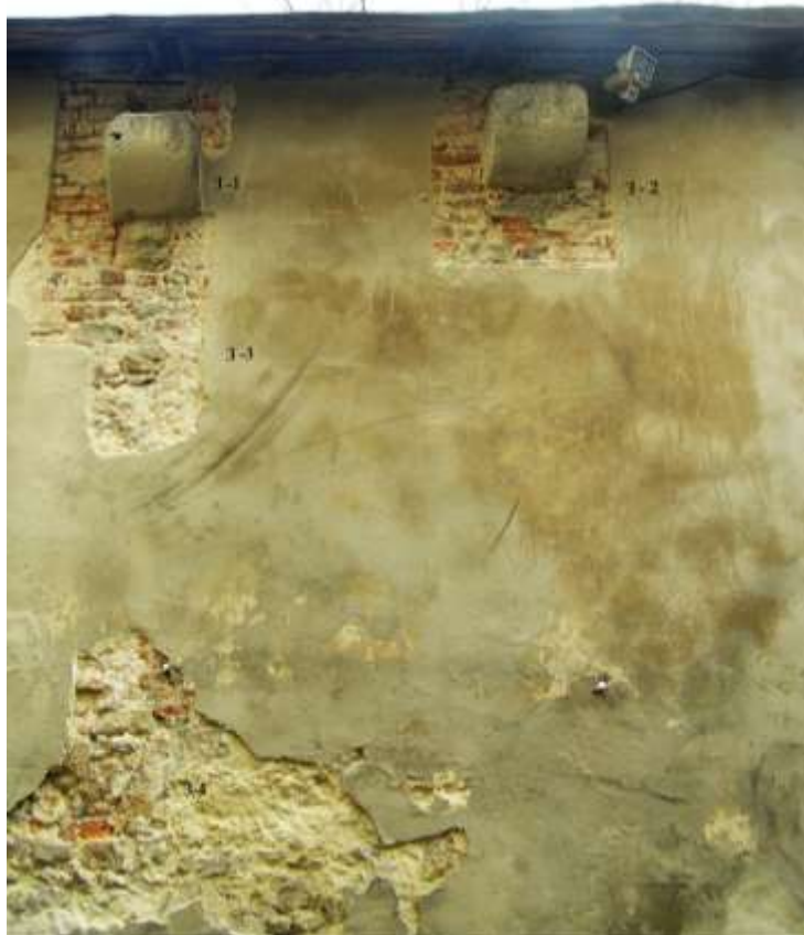
3. Фрагмент високого муру: загальний вигляд з розкриттям мурувань. Фото автора.
