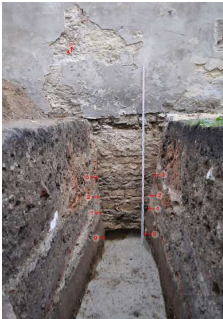
Рис. 6. Археологічний шурф у підніжжі муру: 0 – рівень материка; 1 – фундаментний рів; 2 – уступ фундамета; 3 – мурування без слідів затирки або тиньку; 4 – найнижча верства з додатком цегли у мурування. Фото і опрацювання автора.
