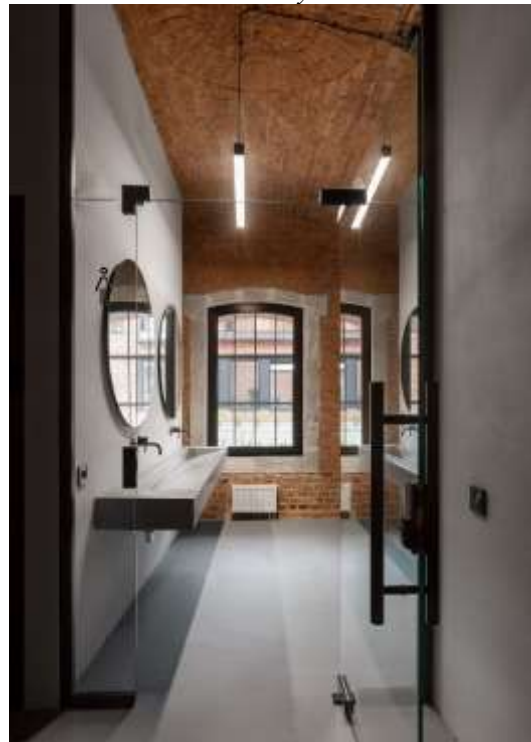
Рис. 13. Реставровані кам'яні обрамлення вікон 2 поверху, які збереглися. На стелі закладка цеглою круглого отвору від ватерклозету.
