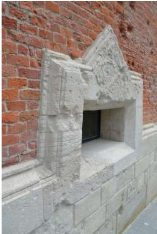
Рис. 12. Деталь брамлення вікна та кам'яний цоколь, виконані з профільованого вапняку
