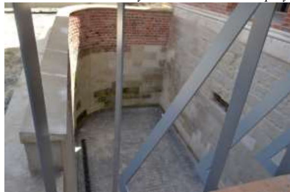
Рис. 19. Вид з містка на підпірну стінку та північну стіну I поверху. Реставрація та перекладка кам'яних блоків. Перекладка цегли підпірної стінки. Накриття стіни кам'яними плитами.
