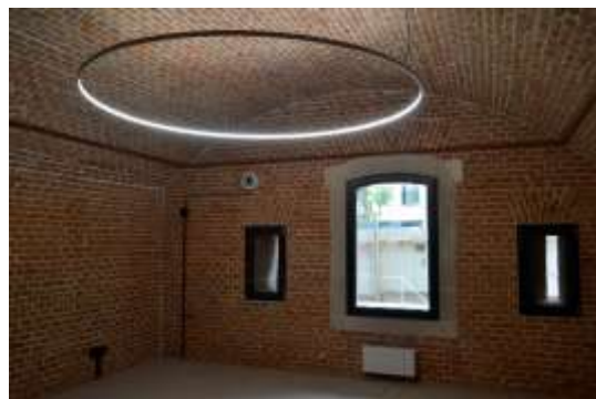
Рис. 15. Інтер'єр приміщення другого поверху
