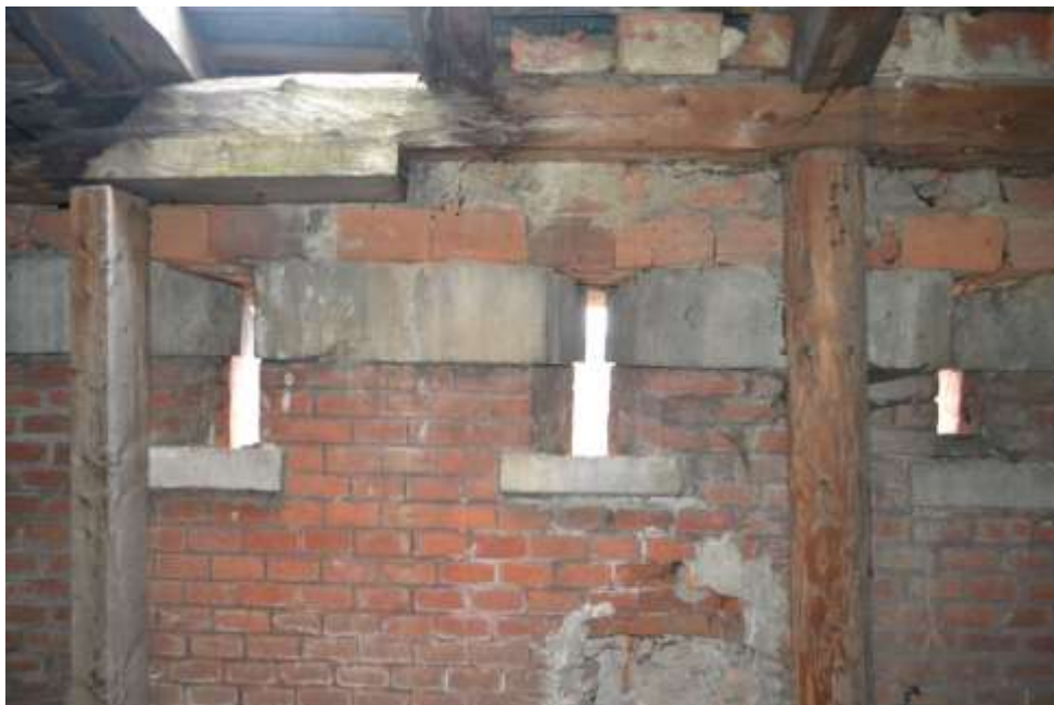
Рис. 4. Конструкція даху, оперта на мерлони. Видляд до реставрації (фото – М.Рибенчук).
