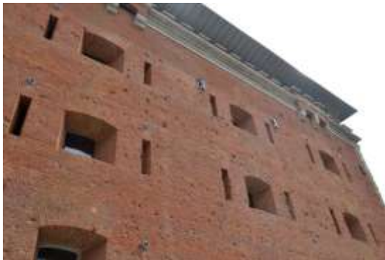
Рис. 10. Фото західної стіни після розчистки експонує сліди від куль, результати боїв, що тут відбувалися
