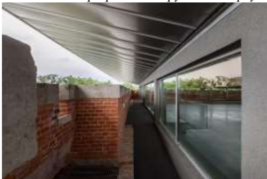
Рис. 18. Обхідна галерея західного фасаду з накриттям
