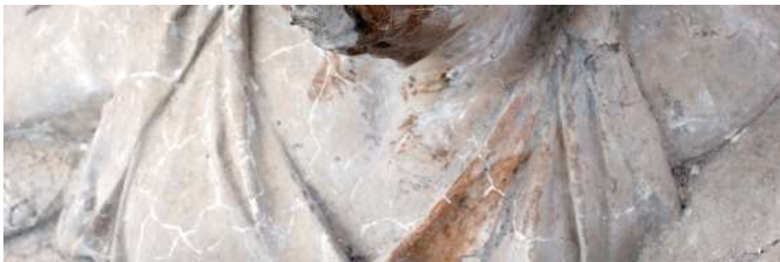
Рис.18. Скульптурна група на вул. І. Франка, 2. Обробка тріщин нановапном. Фото - А.Федоришин.
