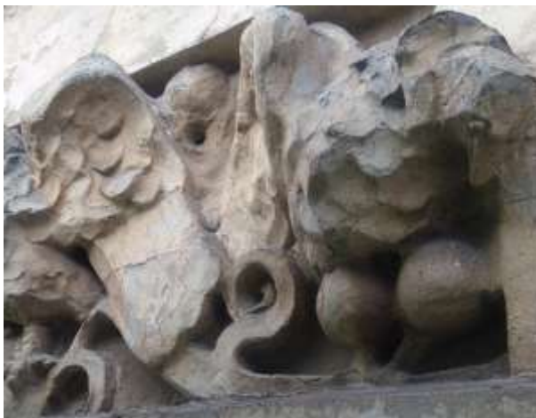
Рис.6. Атланти та рельєфи на вул. Генерала Чупринки, 6. Кракелюр. Фото - А.Федоришин.
