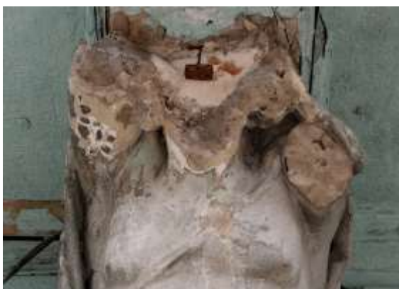
Рис.11. Скульптури на вул. Листопадового Чину, 12. Скульптури без металевго каркасу. Фото - А.Федоришин.
