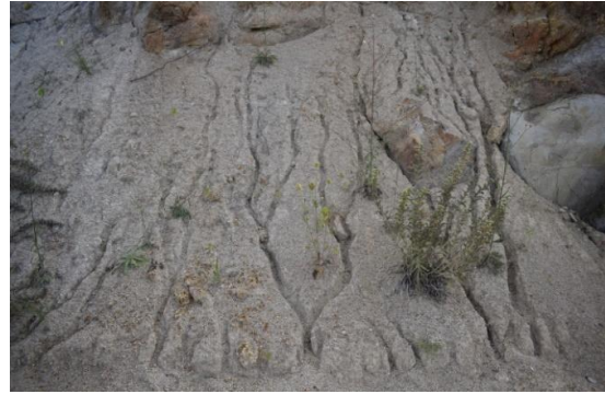
Рис. 14. Паралельна мережа ерозійних мікроборозен на уступі розкривних товщ Сабарівського кар'єру.
