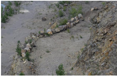
Рис. 6. Запобіжний вал на кар'єрній дорозі (південна частина Гніванського кар'єру).
