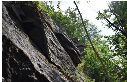
Рис. 10. Місце можливого вивалювання брили на стінці давнього відпрацьованого Сабарівського кар'єру.
