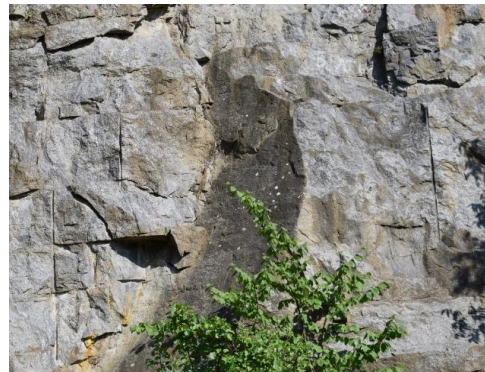
Рис. 2. Сліди свердловинних зарядів на уступі відпрацьованого Сабарівського кар'єру.
