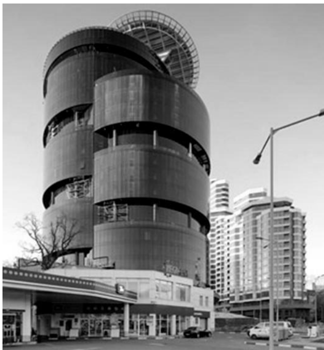
Рис. 4. IQ Business Center у Києві ( https://a-office.com.ua/uk/property/iq-business-center ) Дата звернення 20.02.2024
