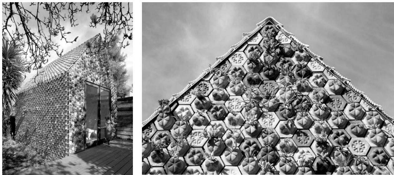
Рис. 1. Павільйон «Кабіна курйозів» (Cabin of Curiosities) в Окленді (2018). Архітектори: Rael San Fratello Architects. Глазурована 3D-друкована керамічна система облицювання, яка служить екраном від дощу. 3D-друкована керамічна система із інноваційними матеріалами добавок для великомасштабного виробництва: сіль, ґрунт, цемент і шардоне. Загальний вигляд спереду; елемент фронтону
