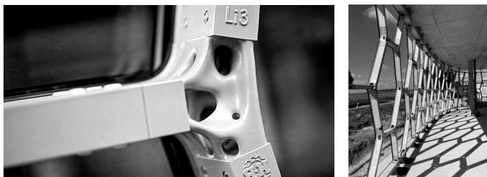
Рис. 5. Серійний вузол параметричного фасаду проєкту «HivE» в Німеччині (2021). 3D-друковані вузли фасадів з оптимізованою топологією «N-AM_Li3». Вузли параметрично генеруються за допомогою розробленого Lithium Designers GmbH (керівник док. А. Мохсен) програмного забезпечення «Li3M». Загальний вигляд вузла; змонтований каркас фасаду
