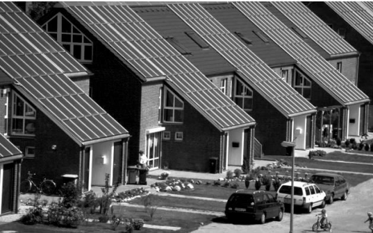
Рис. 8. Панелі, встановлені замість частини дахівки (Stavanger Aftenblad. 2024)
