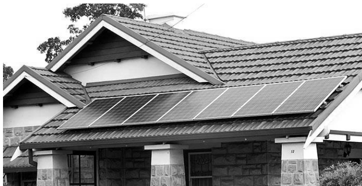
Рис. 5. Сонячні панелі, встановлені на дах поверх черепиці (UnderstandSolar. 2024)
