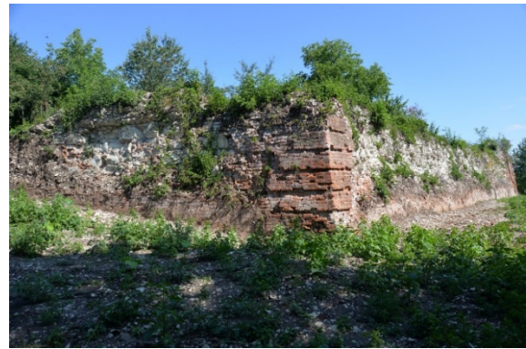
Рис. 11, 12. Деструкція шпигу і лицевого ескарпування бастиона (№2) і правого наріжника між фасом і фланком. 2022 р. Фото З. Федунківа
