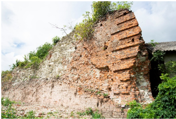
Рис. 11, 12. Деструкція шпигу і лицевого ескарпування бастиона (№2) і правого наріжника між фасом і фланком. 2022 р. Фото З. Федунківа
