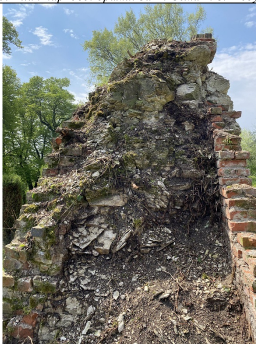
Рис. 16. Деструкція лівої торцевої стінки паркової брами
