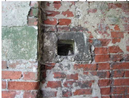
Рис. 6. Отвір для просовування бруса-запору дверей в'їзної брами. 2022 р. Фото А. Магмет
