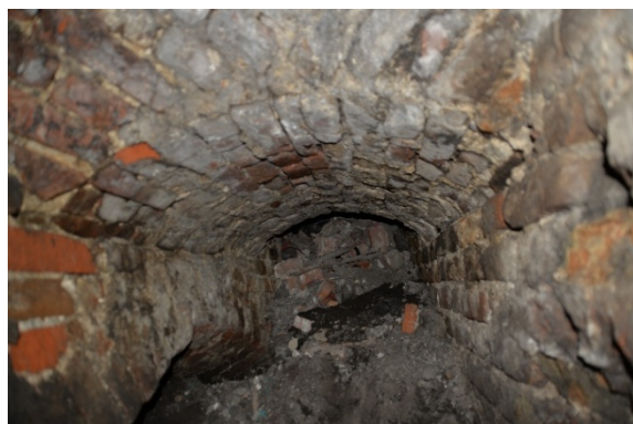
Рис. 21. Склепіння центральної камери і арка засипаного підземного ходу. 2022 р. Фото С. Каблака
