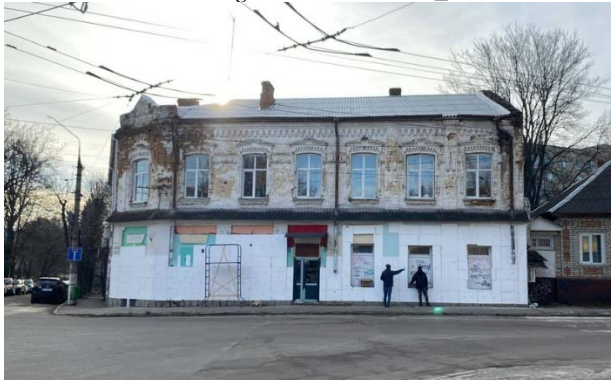
Рис. 5. Утеплення фасаду кам'яниці у м. Житомир.
