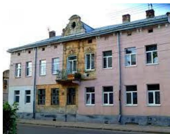
Рис. 4 Утеплення фасаду львівської кам'яниці XX ст. Online доступно: https://portal.lviv.ua/news/2019/01/14/meriya-zaboronila-uteplyuvati-fasadi-budinkiv-v-
