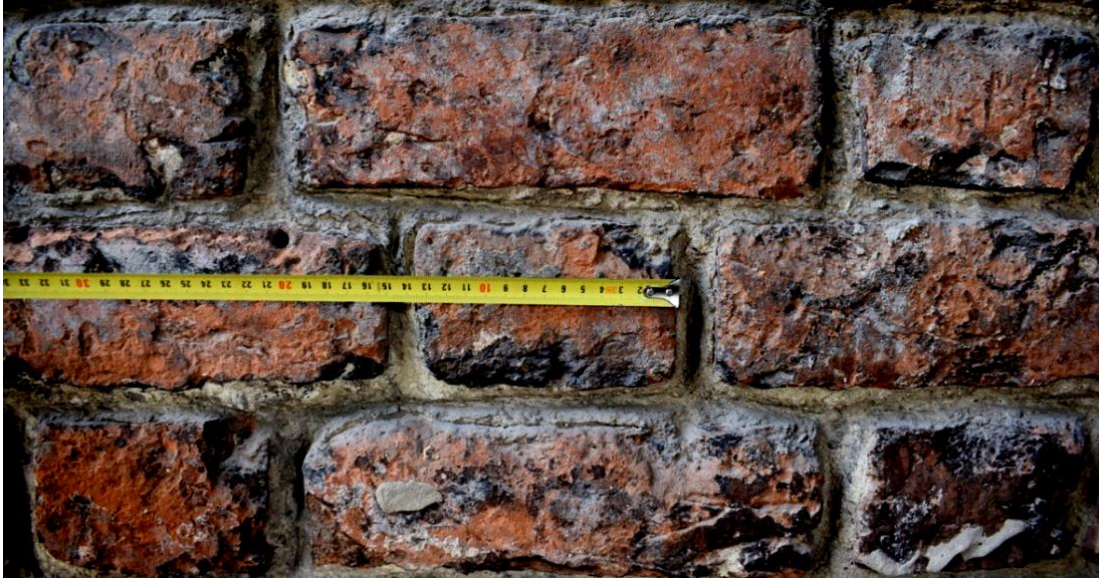
Рис. 11. Цегла готична розмірами 270\text{--}275 \times 230\text{--}135 \times 90 мм на четвертому ярусі вежі Поворозників (з боку галереї на Високому мурі). Фото В. Бевз, 2024
