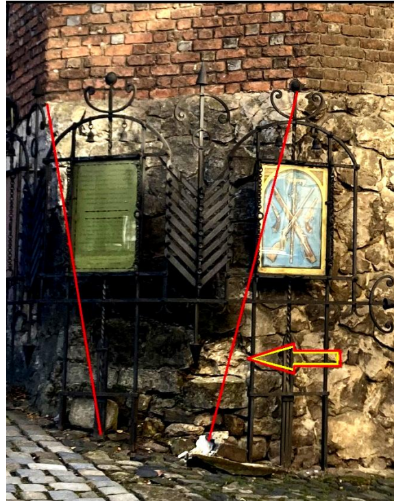
Рис. 13. Стесаний наріжник кам'яної нижньої частини вежі. Стрілкою позначено випадання каменів унаслідок недостатнього в'язання. Опрацювання В. Бевз
