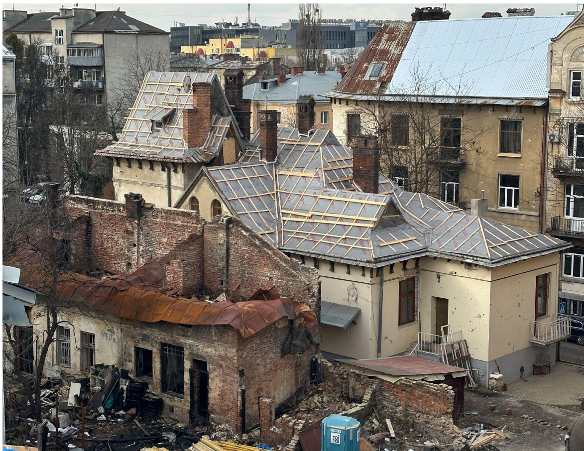
Рис. 13. Вілла Сонячна у Львов (Мельника, 7) після ракетного удару РФ 4 вересня 2024 р. Загальний вигляд з даху будинку на вулиці Коновальця, 44. Консерваційний дах (фото І. Бокало, 28 січня 2025 р.)
