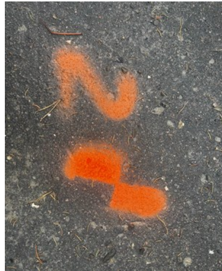
Рис. 1. Маркування контрольних точок фарбою
