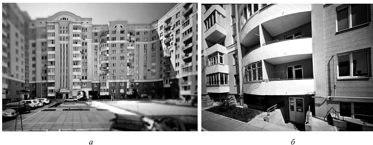
Рис. 1. Загальний вигляд дворових фасадів житлового будинку на вул. Л. Перфецького, 11 і 11а; вид внутрішнього двору (а); фрагмент західного фасаду (б)
