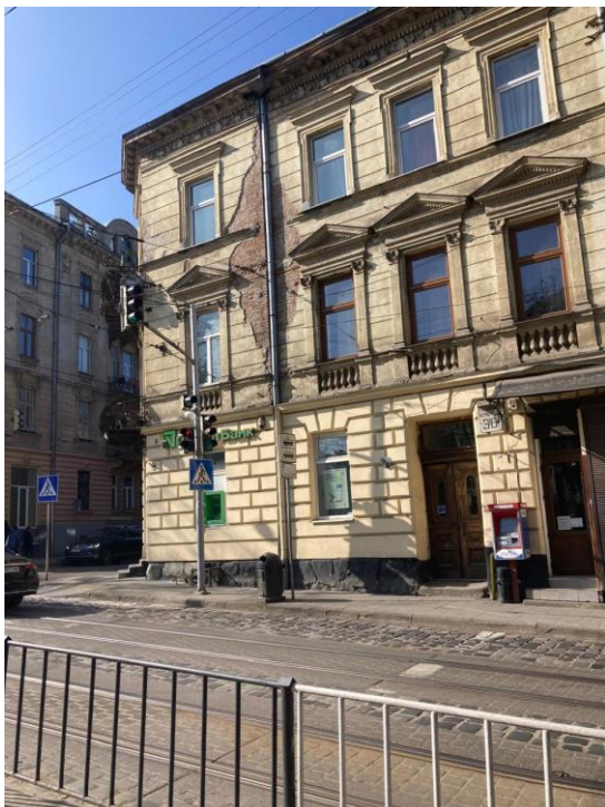
Рис. 3. Руйнування штукатурки на фасадах історичних будівель. Фото автора, 2024 р.
