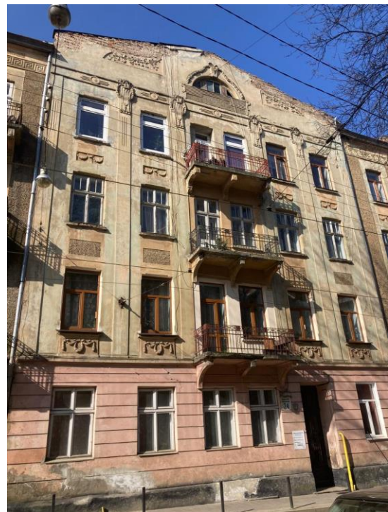
Рис. 3. Руйнування штукатурки на фасадах історичних будівель. Фото автора, 2024 р.
