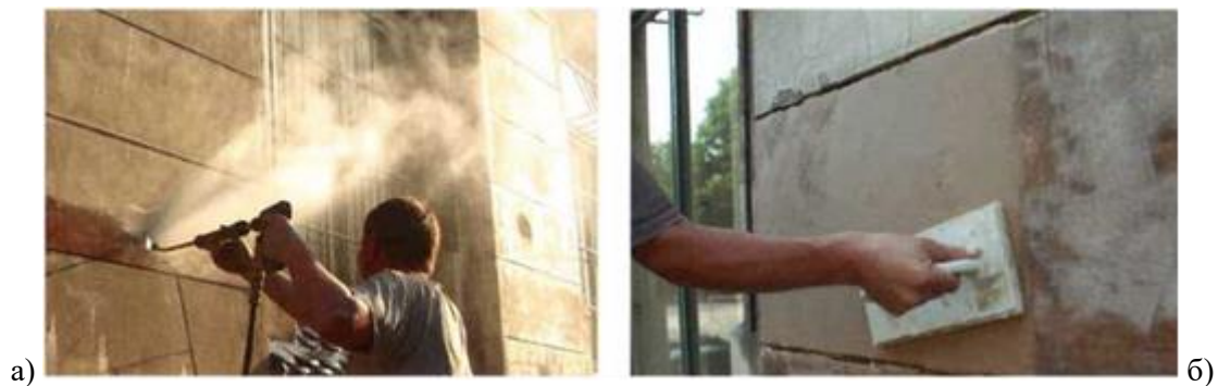
Рис. 4. а) Зняття сучасних покриттів за допомогою гарячої пари.
