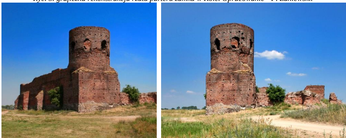
Ryc. 6. Zachowana narożna cylindryczna ceglana wieża z wysokim graniastym cokółem zamku w Kole w 2000 r. (fot. P. Zaniewski).
