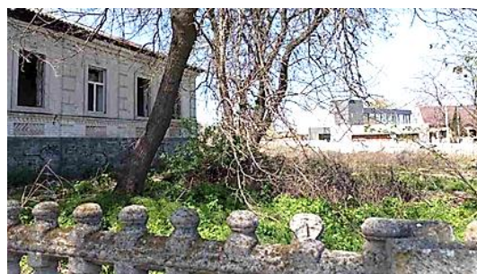
г) підготовлений будівельний майданчик в очікуванні знищення історичної будівлі, колишньої пам'ятки архітектури задля будівництва сучасної багатоповерхівки
