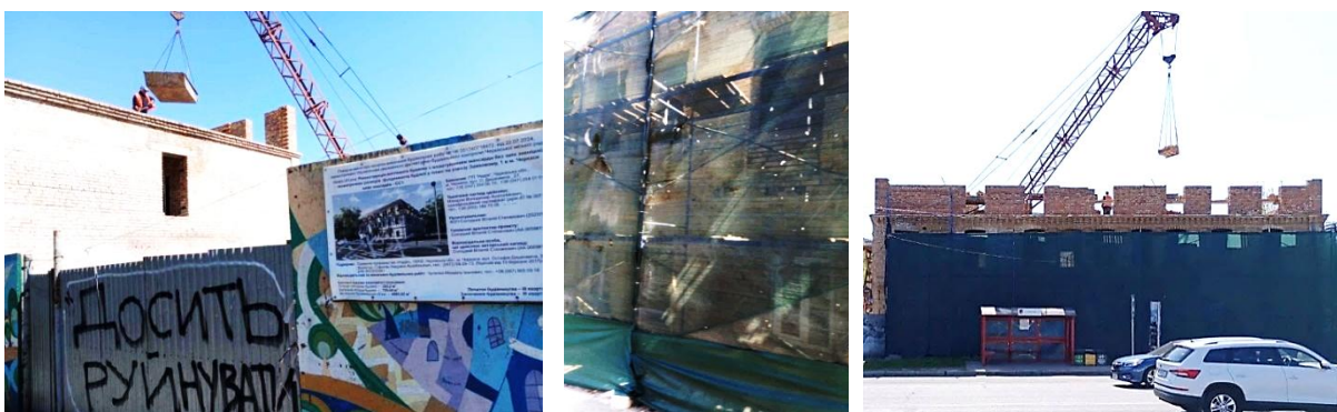
Рис. 3. «Реконструкція історичної будівлі з влаштуванням мансарди без зміни зовнішніх геометричних розмірів фундаментів» та протести городян. Замковий узвіз, 1 (фотофіксація Ю. Денисенка 25.04.2025)
