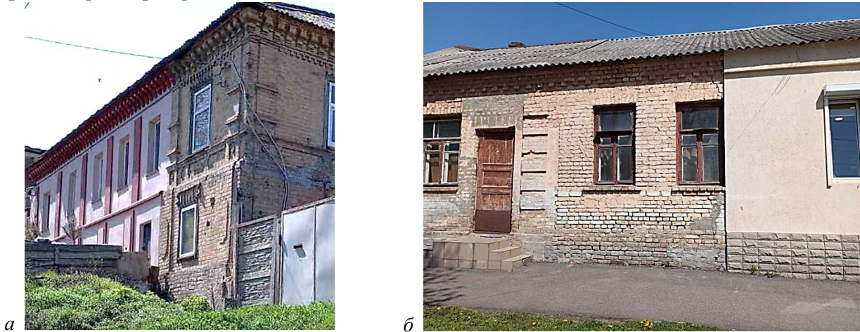
Рис. 2. Приклади традиційного для Черкас «зчищення» автентичного декору з фасадів історичних будівель: а – будинок за адресою вул. Розкопна, 8; б – реконструкція «зчищенням декору» будинку за адресою Хрещатик, 187 (фотофіксація К. Денисенко 25.04.2025)
